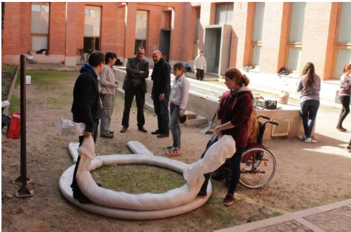
Figura 1.- Inicio de construcción del domo
