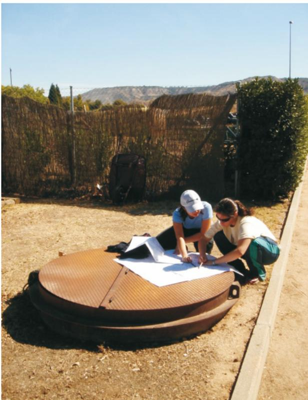
Fotografía 4.- Aspecto del brocal de un pozo excavado con galerías subhorizontales situado en el campus de la Universidad.
